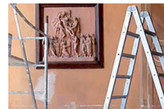
Restaurierung der Loggia
